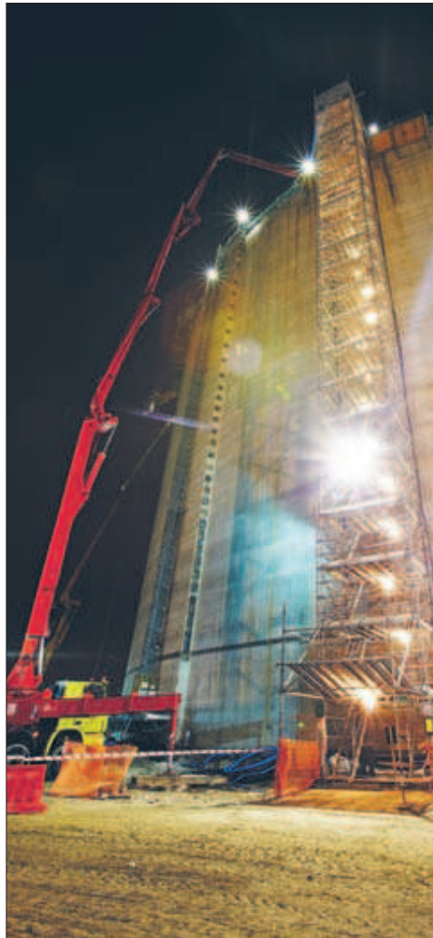
Budowa zbiornika na skroplony gaz ziemny LNG w Świnoujściu
