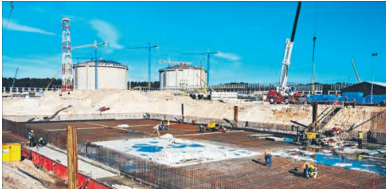
Prace budowlane w świnoujskim terminalu
